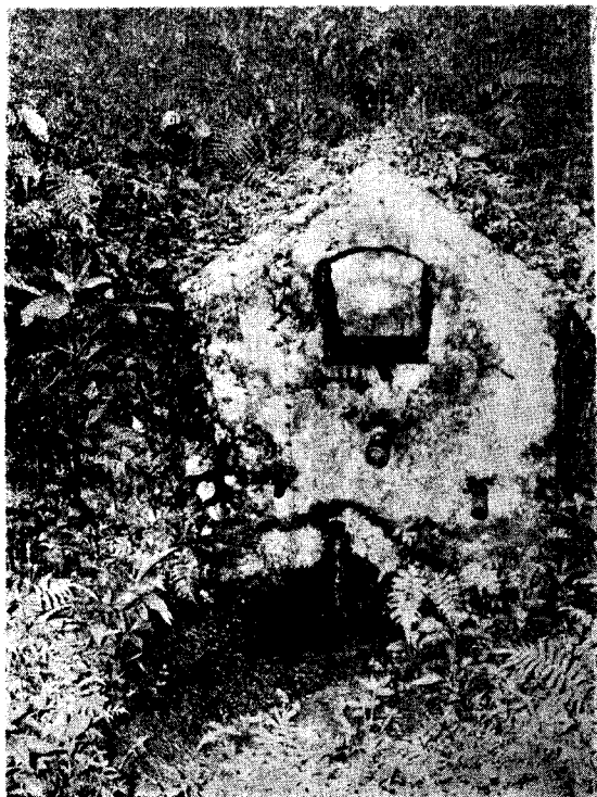
Estado actual de la fuente que surgió en Banapá al arrancar una ceiba
