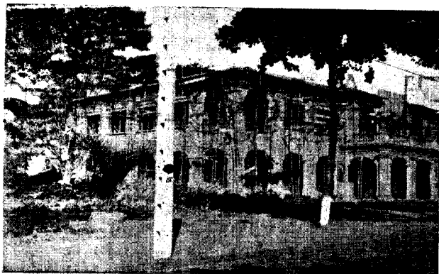
Bata. Edificio del Subgo- bierno, en construcción.
